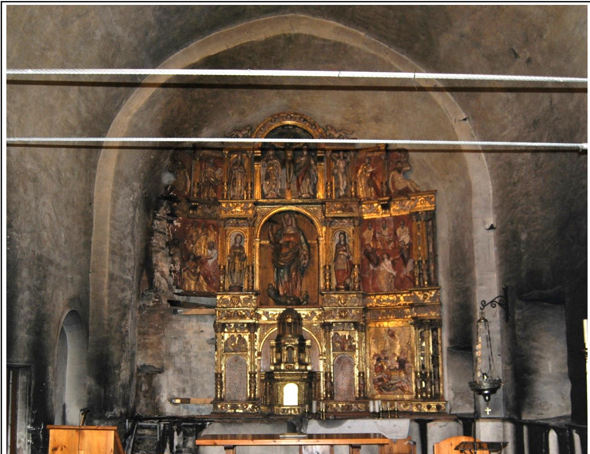
Situación del interior de la iglesia tras el incidente: paredes ahumadas y retablo mayor afectado en su parte izquierda, el relieve y las esculturas del primer cuerpo fueron retirados por los bomberos. © Javier Garcia Bueso
